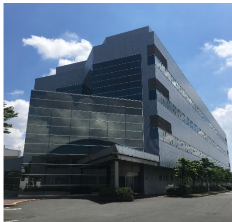
ポーラ化成工業 本社・横浜研究所
